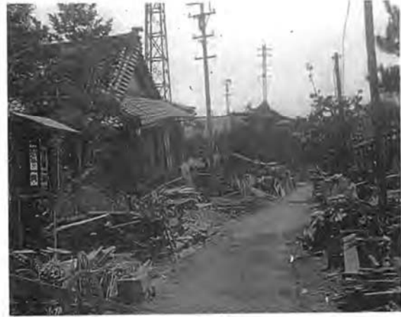
写真 1.1 1948年福井地震での木造家屋の被害 (小林啓美氏撮影)
